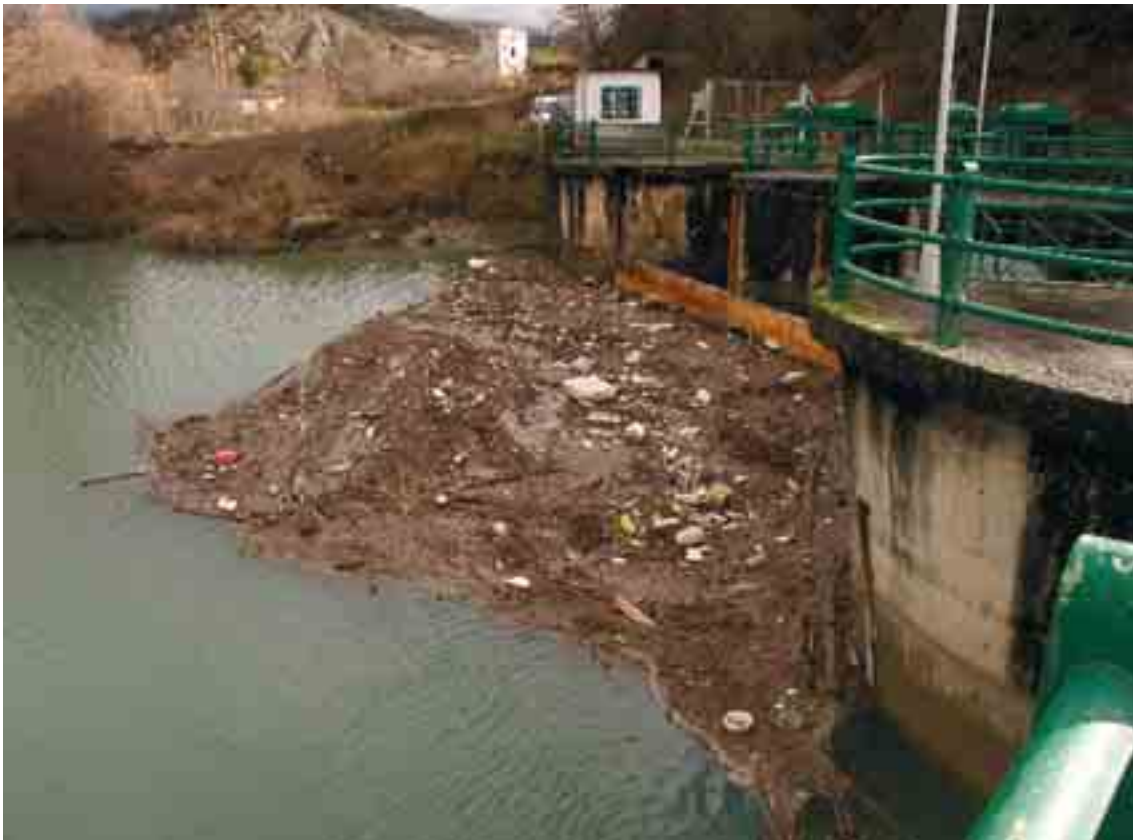
Acumulación de arrastres diversos en la presa de Sabiñanigo (Río Gallego, Huesca).
