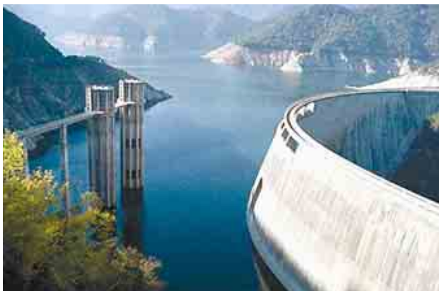
Embalse de Susqueda. Vista de la presa con las torres de toma.
